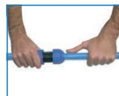
**4. ROSCAR:** Manualmente efectuar un giro de 1/2 vuelta, asegurando la unión mediante la llave específica verificando y garantizando el perfecto apriete de la pieza.
