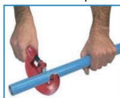
**1. CORTE:** Utilizar herramientas adecuadas que proporcionen un corte limpio y rectilíneo.
