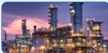
Generación de gases industriales
